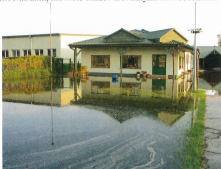
Rys. 5. „Powódź”. Niewielki budynek biurowy w Kostrzynie nad Odrą (Szumiłowo) początek czerwca 2010 r.
