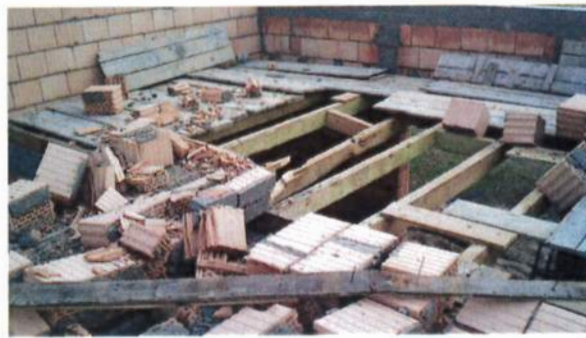
Fot. 6 Zniszczenia stropu drewnianego (jednego z trzech elementów budynku). Stan na dzień: 13.09.2011 r. (z archiwum autora)
